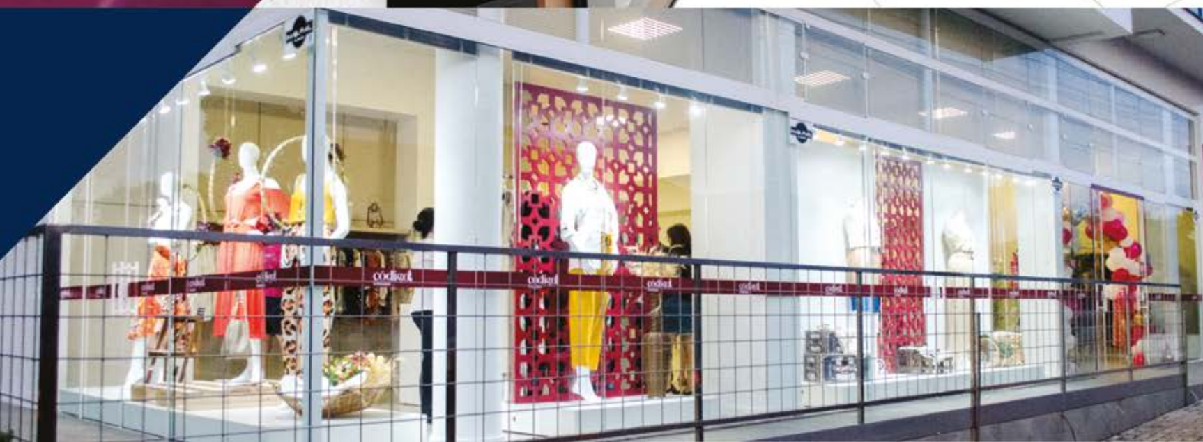
Painéis em arabesco confeccionados em chapa de MDF na fachada da loja Código Feminino, em Pinhalzinho/SC. Projeto do Arquiteto Arlei Tauchert
