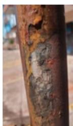
Naturalmente os tubos de aço galvanizado, que estão conectados à bomba, sofrem desgaste oxidativo. Essa ocorrência de ferrugem, corrói a parede dos tubos e as roscas, por onde são conectados, ocasionando furos ou até mesmo rompimento de suas conexões.
