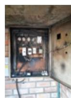
O quadro de comando do poço tubular, quando não possui as peças corretas de proteção, em casos de surtos de tensão ou descargas elétricas, pode queimar a maioria das peças e, conseqüentemente, levar a queima do equipamento submerso.
