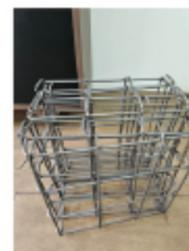
A sapatá é uma base de concreto que transfere o peso de uma construção para o solo.
